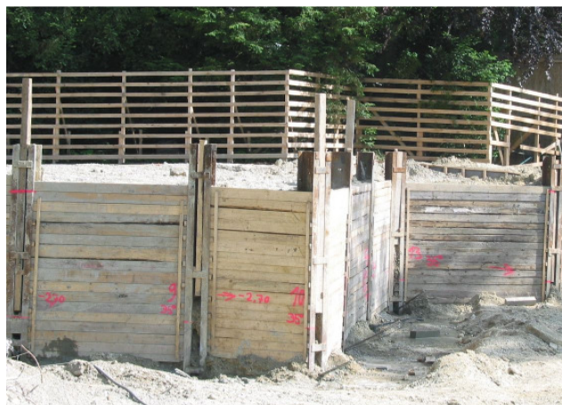
Abbildung 3: Berliner Verbau und Baumschutzzaun
